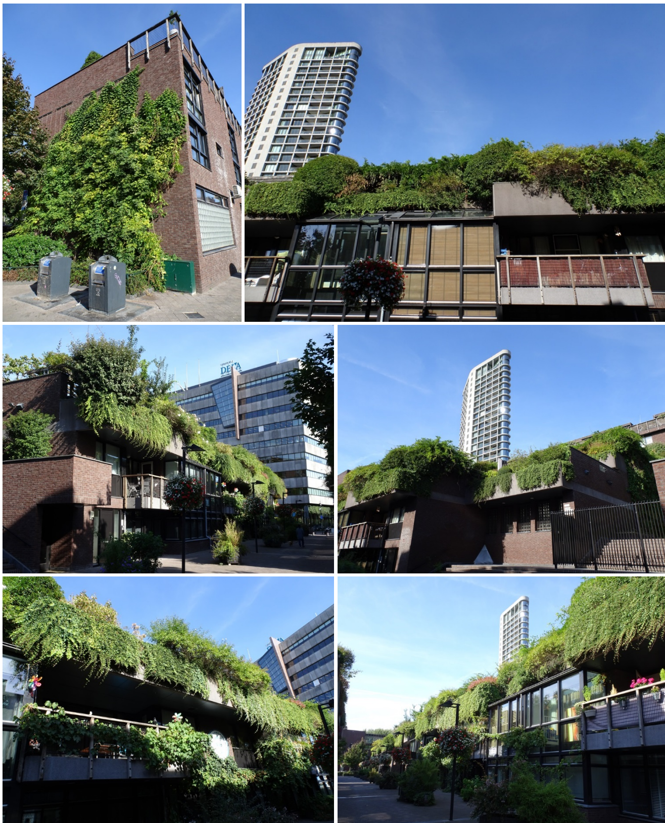
Figuur 7. Voorbeeld van gevelbeplanting in hangende tuinen aan de Smalle Haven en 't College in Eindhoven.
